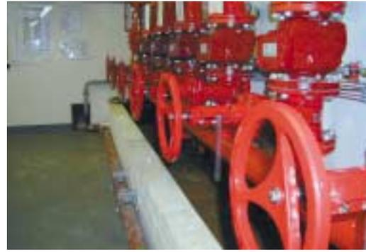
An die 16 Loopteilungen der Brandmeldezentrale ist eine Sprinkleranlage mit rund 6.000 Sprinklern angeschlossen.
