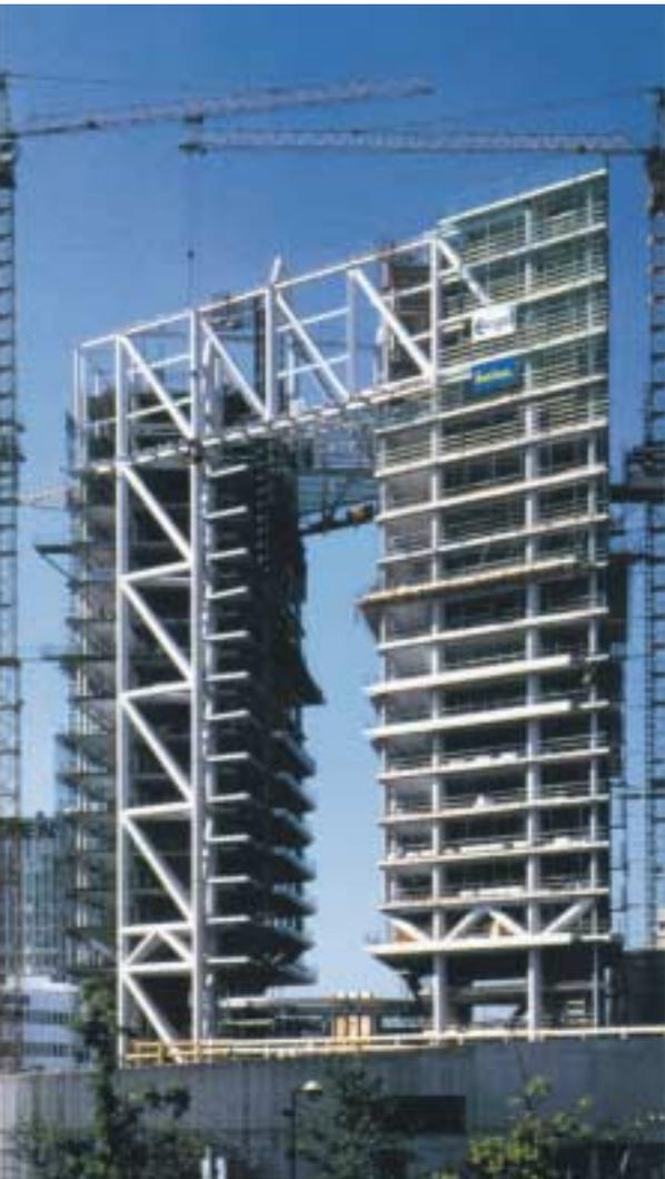
Die beiden Bürotürme sind in den Attikageschossen durch dreigeschossige Fachwerkträger verbunden.
