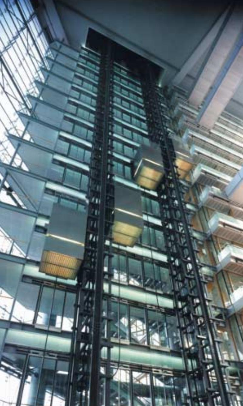
Die insgesamt acht OTIS-Aufzüge sind dank einer „Rucksackaufhängung“ nur an einer Seite mit dem tragenden Stahlgerüst verbunden.
